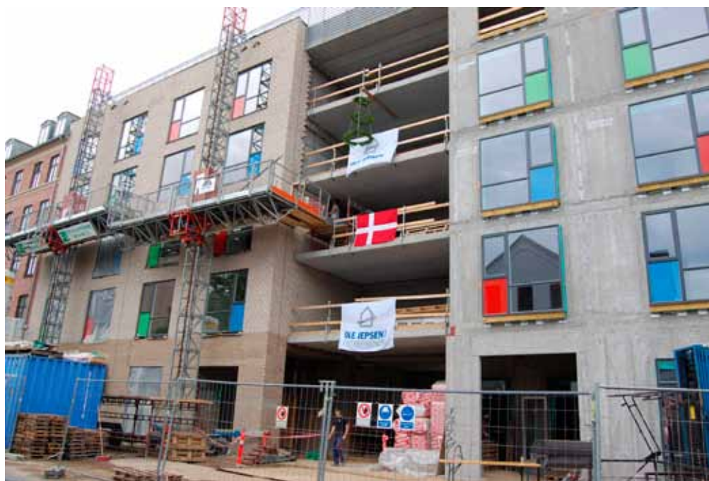
Rejsegilde på byggeriet på Rentemestervej i april 2013.
